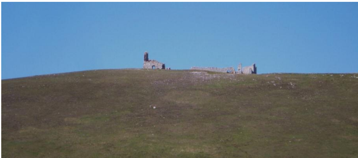
Fig. 8 - I resti di Santa Maria del Monte di Paganica a Campo Imperatore
